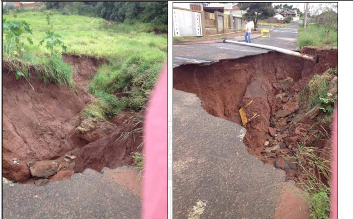
Foto 1 e 2: Processos erosivos na área institucional do loteamento Marajoara. Vista parcial da Rua Marcio Cerqueira Vieira em local que havia dissipador que foi destruído pelas chuvas torrenciais em 2016, formação de processo erosivo (ravina) e destruição de parte da rua.
