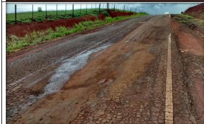
**Foto 49: Patologias do pavimento. Formação de "painéis" e trincas de tração.**
