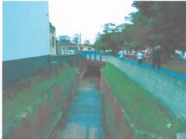
FOTO 49. Vista geral, de montante para jusante, do ribeirão Lageadinho, nas proximidades da área central, via Cap. Cesário.
