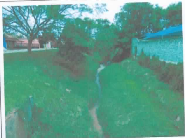
FOTO 58. Vista geral de trecho em canal natural do ribeirão Lageadinho. Notar dimensões das margens, curso d'água e proximidade das moradias na margem esquerda.
