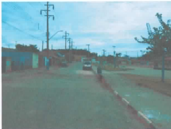
FOTO 25. Vista de moradias, estabelecimentos comerciais e vias afetados pelas inundações do ribeirão dos Carrapatos.
