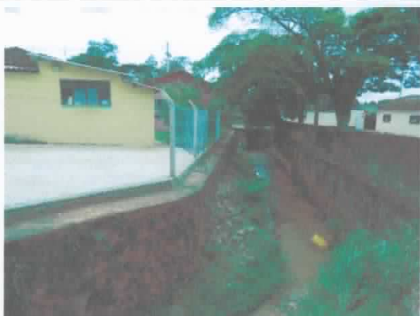
FOTO 51. Vista geral de trecho a montante dos locais mostrados nas FOTOS 45 a 50. Notar dimensões do canal e distância das moradias.
