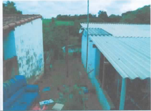
FOTO 38. Vista geral de área afetada pelas cheias do ribeirão dos Carrapatos. Notar, ao fundo, o ribeirão, e o padrão construtivo das moradias. Não foram observados sinais de movimentação do terreno neste trecho.
