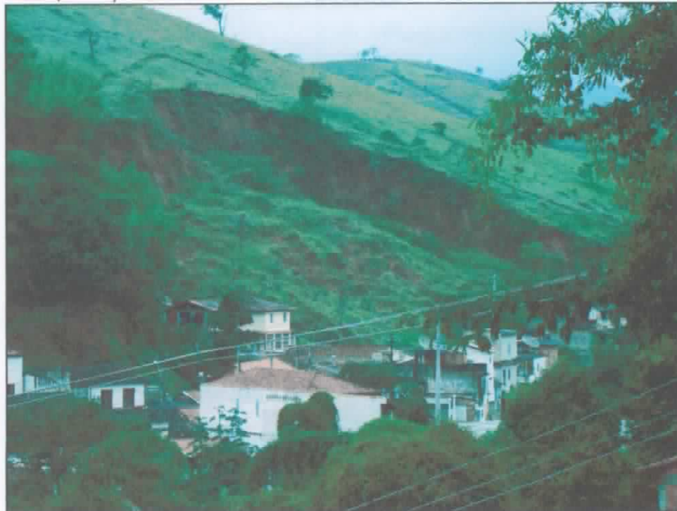
Figura 6 – Deslizamento circular ou rotacional (Fonte: Sirden-CTGeo-IPT).
