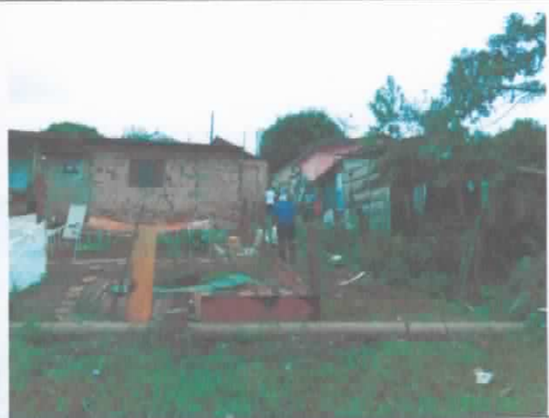
FOTO 2. Vista a partir da margem esquerda do ribeirão dos Carrapatos. Segundo informações da equipe da Comdec e dos moradores, as águas chegam a atingir a base das moradias. Notar padrão construtivo e características do talude marginal. Destaque, também, para tubulação de esgoto.
