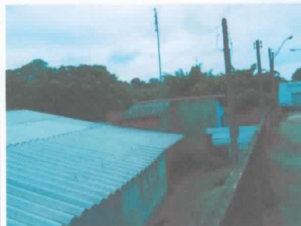
FOTO 39. Vista geral de renque de moradias nas proximidades da rua 2.
