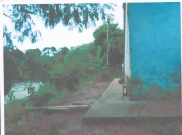
FOTO 41. Vista de aterro construído para elevação dos terrenos e construção de moradias.
