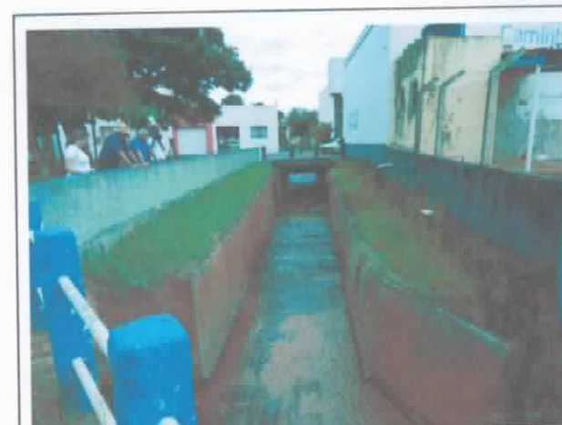
FOTO 47 Vista geral do ribeirão Lageadinho, na região central do município. Devido a frequentes inundações no local, a drenagem foi retificada, com ampliação do canal e das galerias.
