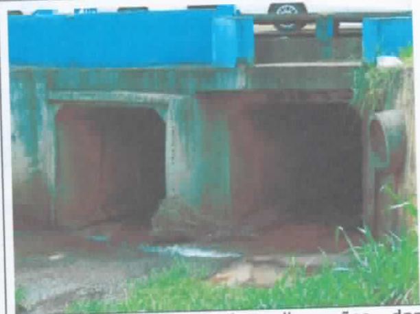
FOTO 60. Detalhe das dimensões das aduelas de concreto mostradas na FOTO 59.
