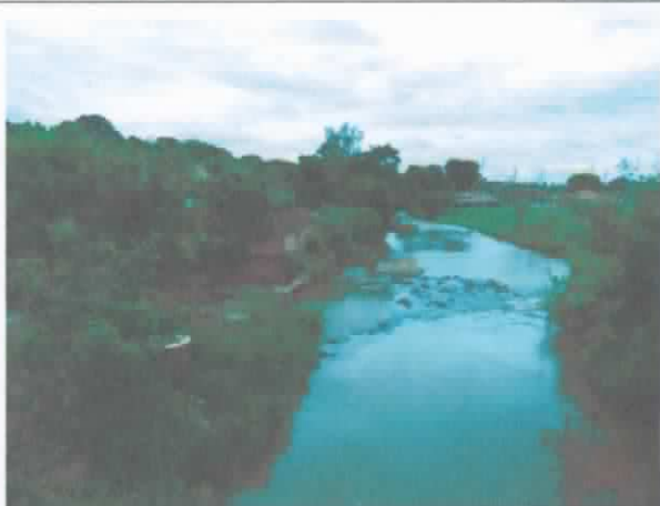
FOTO 15. Vista geral, de montante para jusante, do ribeirão dos Carrapatos e encontro com o ribeirão Lajeado (margem esquerda). Notar dimensões da drenagem, cobertura vegetal e tubulação de esgoto.
