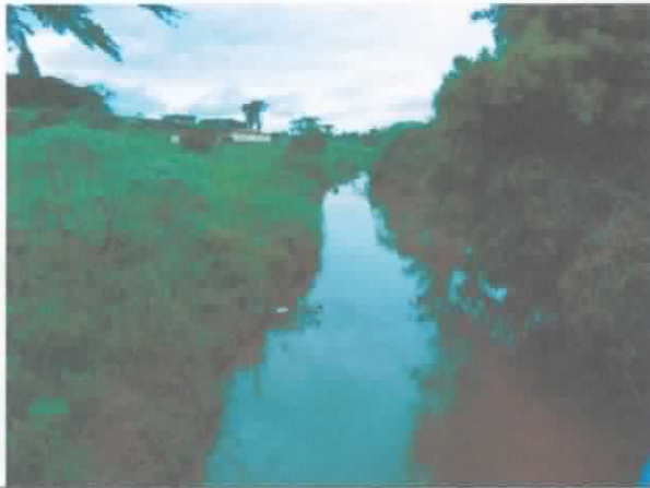
FOTO 13. Vista geral, de jusante para montante, do ribeirão dos Carrapatos. Notar cobertura vegetal em ambas as margens e características geométricas da drenagem. Imagem obtida a partir da ponte mostrada na FOTO 14.
