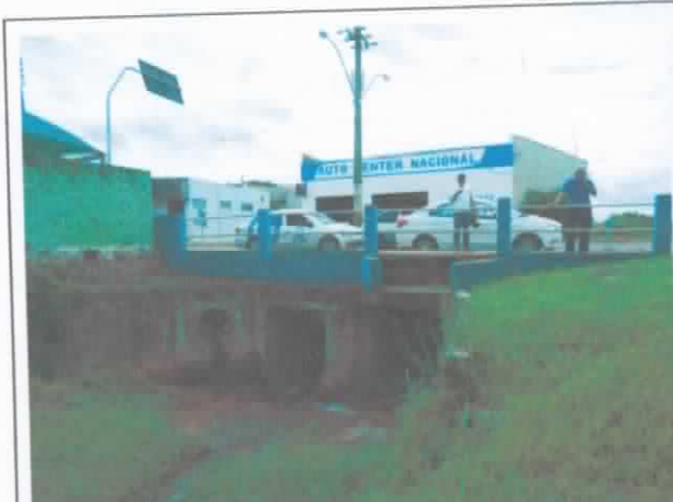
FOTO 59. Vista de travessia de drenagem nas proximidades da Av. Santo Antônio. Notar dimensões das aduelas de concreto.
