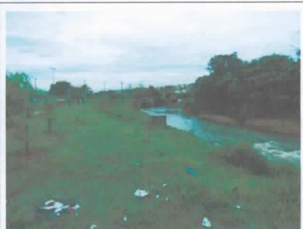
FOTO 24. Vista geral, de jusante para montante, do ribeirão dos Carrapatos em trecho comumente afetado pelas inundações.
