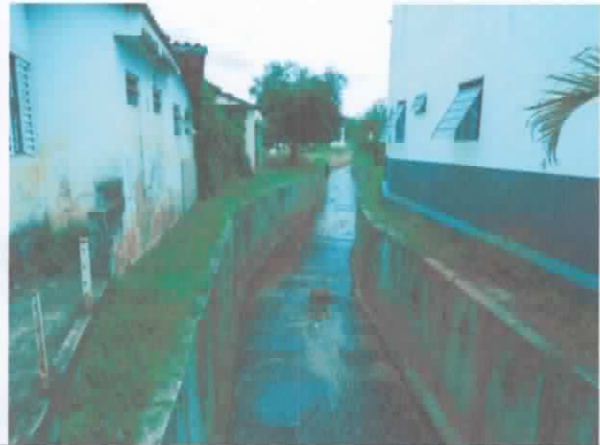
FOTO 50. Vista geral de trecho retificado do ribeirão Lageadinho. Notar proximidade das moradias e dimensões do canal.
