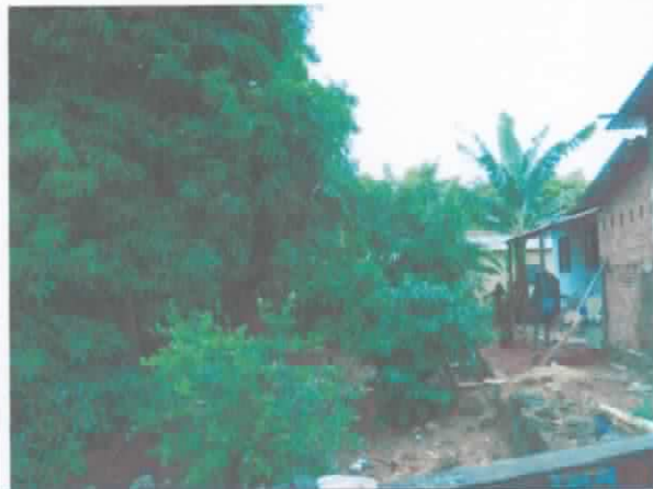
FOTO 37. Vista geral, de jusante para montante, de renque de moradias, padrão popular, construídas na margem esquerda do canal de drenagem.
