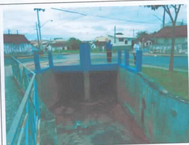
FOTO 56. Vista de trecho retificado com ampliação das galerias.
