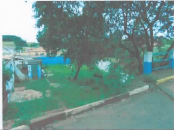
FOTO 26. Vista de trecho localizado na margem direita do ribeirão no qual ocorreram algumas demolições e realocação de moradores em função do impacto das inundações.
