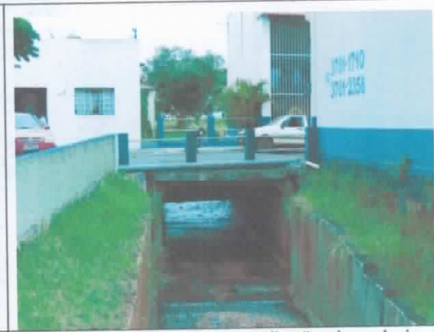
FOTO 48. Registro da ampliação de galeria e retificação do canal de drenagem. Notar dimensões do vão e proximidade das moradias e comércio.
