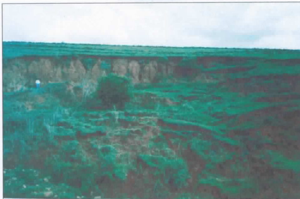
Figura 2 – Árvores inclinadas e degraus de abatimento indicando processos de rastejo (Ministério das Cidades, Instituto de Pesquisas Tecnológicas do Estado de São Paulo – IPT, 2007).
