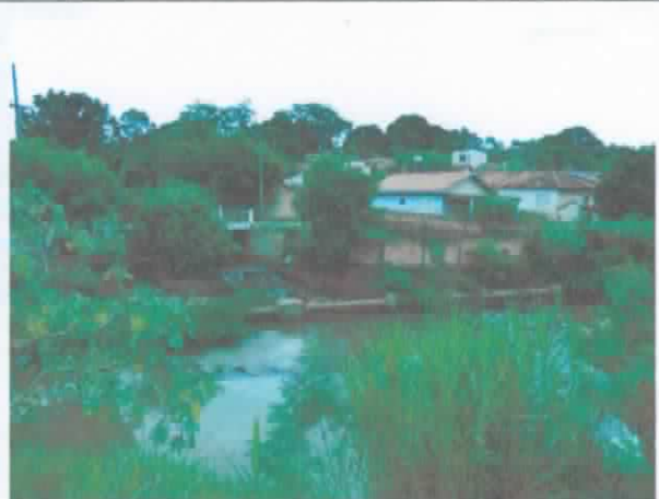
FOTO 16. Vista do encontro do ribeirão Lageadinho com o dos Carrapatos. Segundo informações da Comdec, as moradias localizadas na margem direita não são atingidas pelas inundações.
