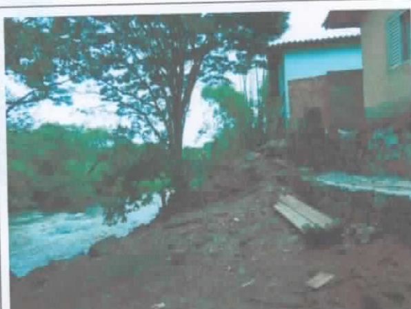
FOTO 32. Vista de moradias localizadas na margem esquerda do ribeirão dos Carrapatos. Notar aterros executados para elevação do terreno natural.
