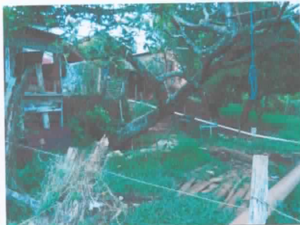
FOTO 7. Vista de moradias localizadas na margem esquerda do ribeirão dos Carrapatos. Notar padrão construtivo e patamares (aterros) construídos para elevação do terreno.
