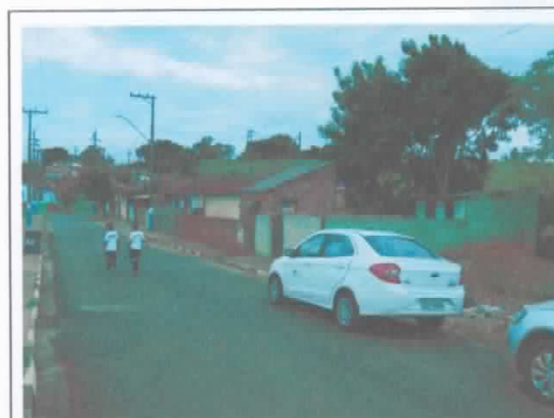
FOTO 19. Vista geral das moradias localizadas na margem direita do ribeirão dos Carrapatos. Em função das dimensões do córrego, da distância das moradias em relação à margem do ribeirão, da proteção vegetal presente na área e das condições topográficas da bacia, não houve, até o presente momento, registro de grandes impactos no bairro.
