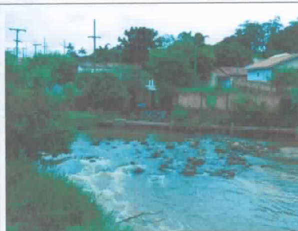
FOTO 20. Vista do encontro dos ribeirões Lageadinho e dos Carrapatos, com destaque para a tubulação de esgoto e galerias (ao fundo) executadas para reduzir a possibilidade de inundações provocadas pelo ribeirão Lageadinho.
