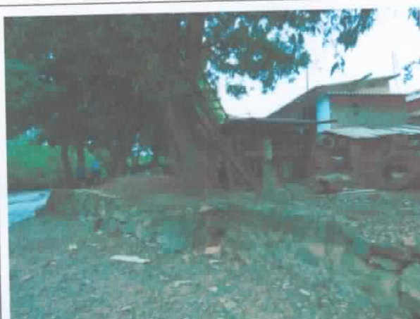
FOTO 30. Vista geral de área afetada pelas cheias do ribeirão dos Carrapatos. A área afetada encontra-se na margem esquerda da drenagem.
