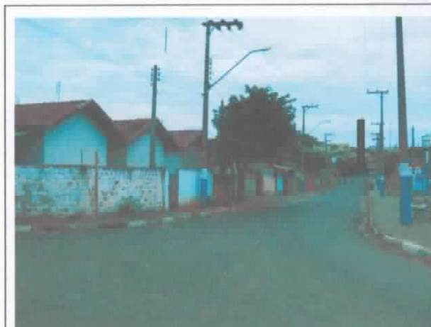
FOTO 23. Vista geral das moradias que são mais atingidas durante as inundações do ribeirão dos Carrapatos. Ao fundo (seta) ponte mostrada na FOTO 14.
