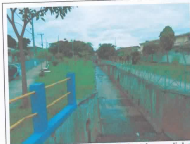
FOTO 55. Vista geral do ribeirão Lageadinho. Notar dimensões e geometria do canal após obras de retificação.
