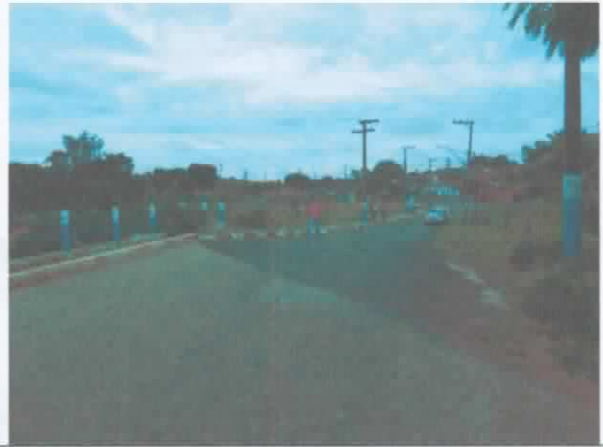
FOTO 14. Vista geral de área afetada pelas cheias do ribeirão dos Carrapatos. A área afetada encontra-se na margem direita da drenagem.
