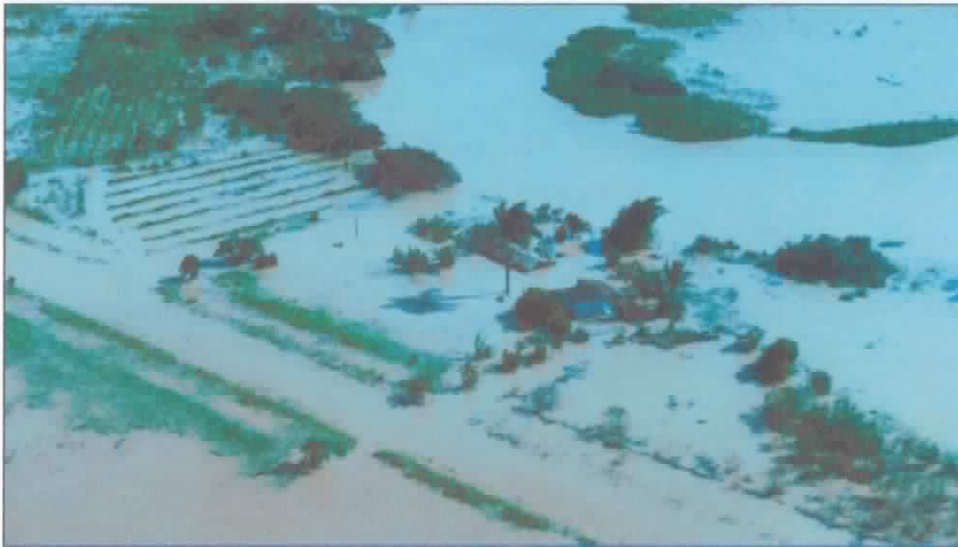
Figura 17 – Inundação de terrenos marginais (Ministério das Cidades, Instituto de Pesquisas Tecnológicas do Estado de São Paulo – IPT, 2007).
