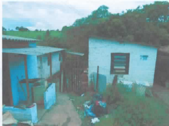
FOTO 34. Vista geral de área afetada pelas cheias do ribeirão dos Carrapatos. A área afetada encontra-se na margem esquerda da drenagem. Segundo informações da Comdec e dos moradores, as cheias atingem apenas os quintais das moradias (ao fundo). Notar padrão construtivo das moradias.
