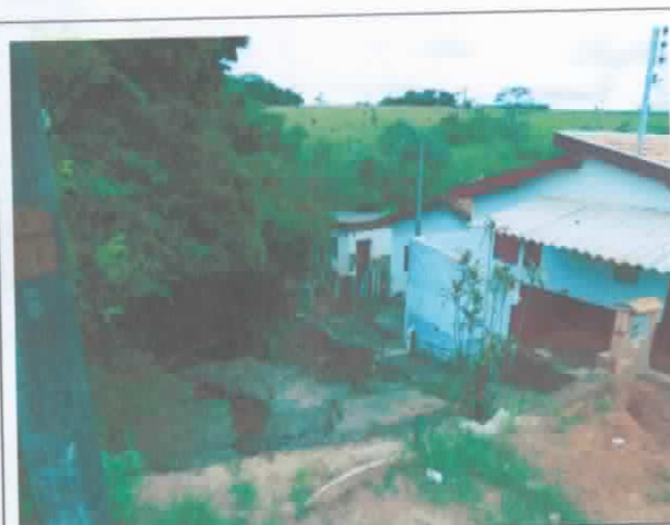
FOTO 12. Vista de moradias localizadas na margem esquerda do ribeirão dos Carrapatos e sistema de coleta de águas pluviais que passa lateralmente às moradias.
