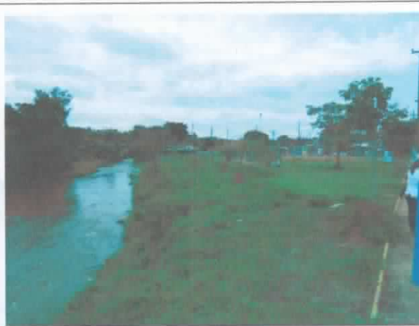
FOTO 18. Vista geral da margem direita do ribeirão dos Carrapatos e praça Tiago Nileto. A área é comumente afetada pelas inundações da drenagem.
