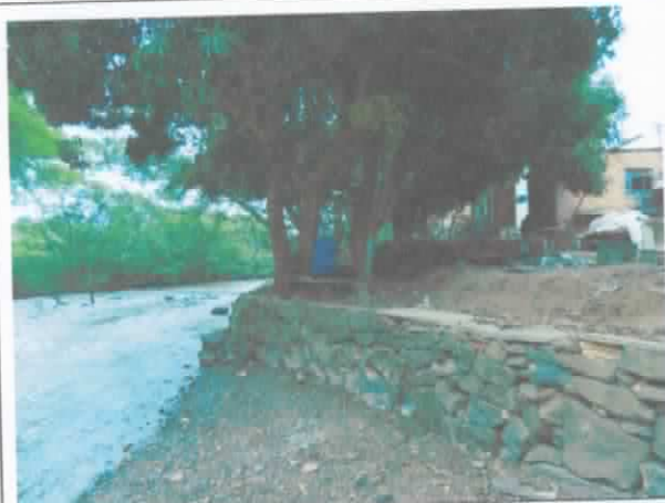
FOTO 29. Vista geral, de jusante para montante, do ribeirão dos Carrapatos. Notar distância das moradias em relação à drenagem e aterros executados, com alteamento do terreno.
