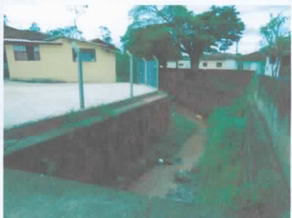
FOTO 52. Vista geral de trecho a montante dos locais mostrados nas FOTOS 45 a 50. Notar dimensões e geometria do canal e distância das moradias.
