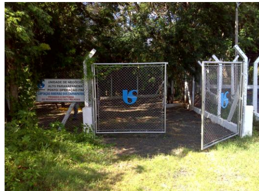
FOTO 4.1 - CAPTAÇÃO NO RIBEIRÃO CARRAPATOS.
