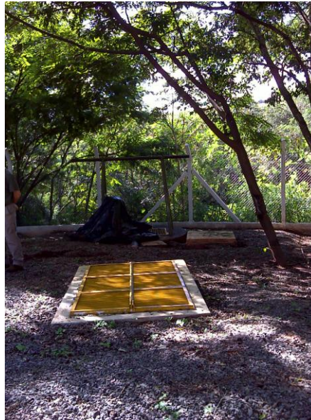
FOTO 4.2 – ESTAÇÃO ELEVATÓRIA DE ÁGUA BRUTA DE ITAÍ.
