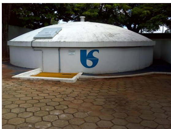
FOTO 4.7 – RESERVATÓRIO SEMI ENTERRADO DE 300M 3 , ESCRITÓRIO SABESP ITAÍ.
