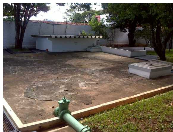
FOTO 4.8 – RESERVATÓRIO ENTERRADO DE 200 M 3 , ESCRITÓRIO SABESP ITAÍ.
