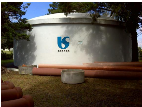
FOTO 4.9 – RESERVATÓRIO DE 500 M 3 , JARDIM NOVO HORIZONTE, ITAÍ.
