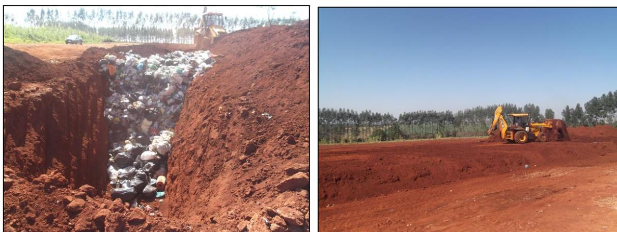
**Figuras 18 e 19: Aterro em operação, com vala sendo coberta por máquina retroescavadeira, sem a presença de catadores e animais, cercado por vegetação e com cerca de isolamento.**
