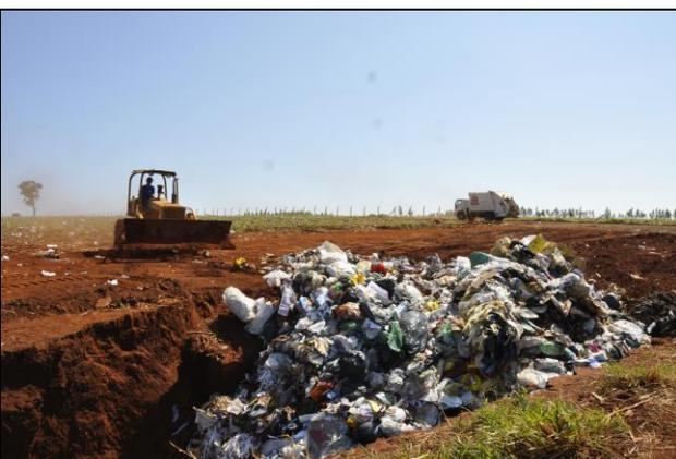
**Figuras 08 e 09: Novo Aterro em processo de operação. Caminhão recebendo do FECOP fazendo a descarga de Resíduos Domiciliares. (Início da utilização da área em 2010).**
