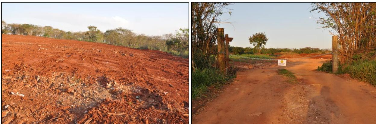
**Figuras 2 e 3: Antigo Aterro em processo de adequação. Resíduos foram enterrados, a topografia foi corrigida e foi isolada a entrada de veículos.**
