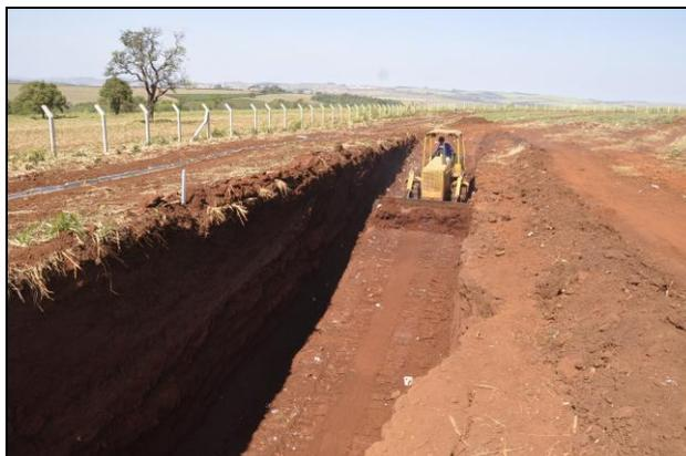
**Figuras 06 e 07: Aterro em valas localizado na Fazenda Sarita do Pouso Alegre. Vista parcial de uma das laterais, na qual se observa o isolamento da área, plantio de eucalipto para formação da barreira vegetal e instalação de canaletas para escoamento das águas pluviais. (Início da operação em 2010).**
