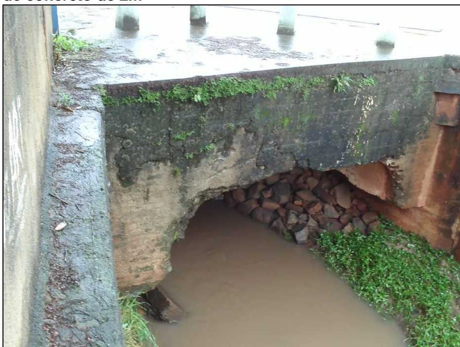
Foto 13.- Travessia sobre o Cór. Lageado (R: Doze de outubro) – aduela de concreto de 2m 2
