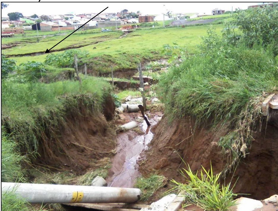
Foto 19.- Outra visão do Poste de energia caído na R: José da Rosa Goulart, área de uma das nascentes do Córrego do Lageado (formação de Erosões)
