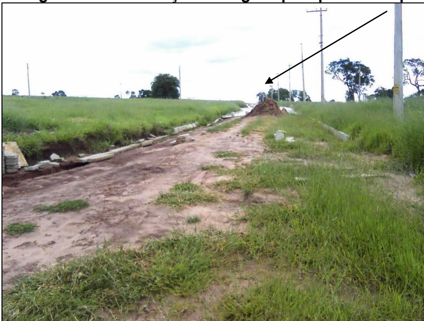
Foto 20.- Vista parcial da área onde se pretende adotar a medida emergencial de contenção das águas precipitadas na pastagem (acima)
