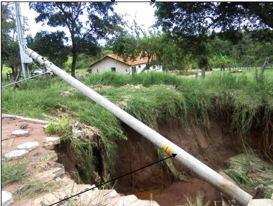
Foto 18.- Poste de energia caído na R: José da Rosa Goulart, área de uma das nascentes do Córrego do Lageado
