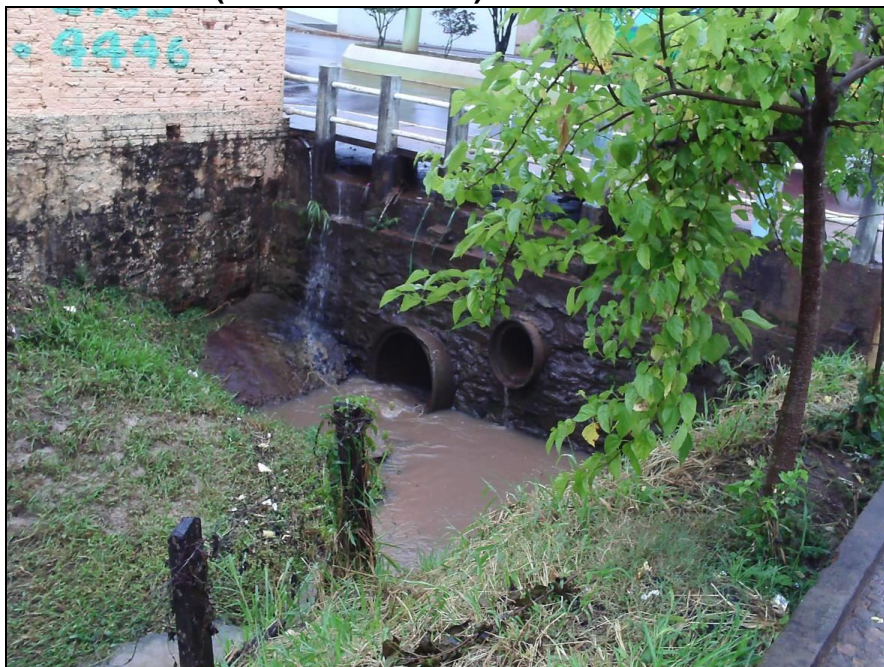
Fotos 1 e 2.- Travessia sobre o Córreg. Lageado – tubos com diâmetros de 60cm e 80cm (Av. Sto. Antonio)
