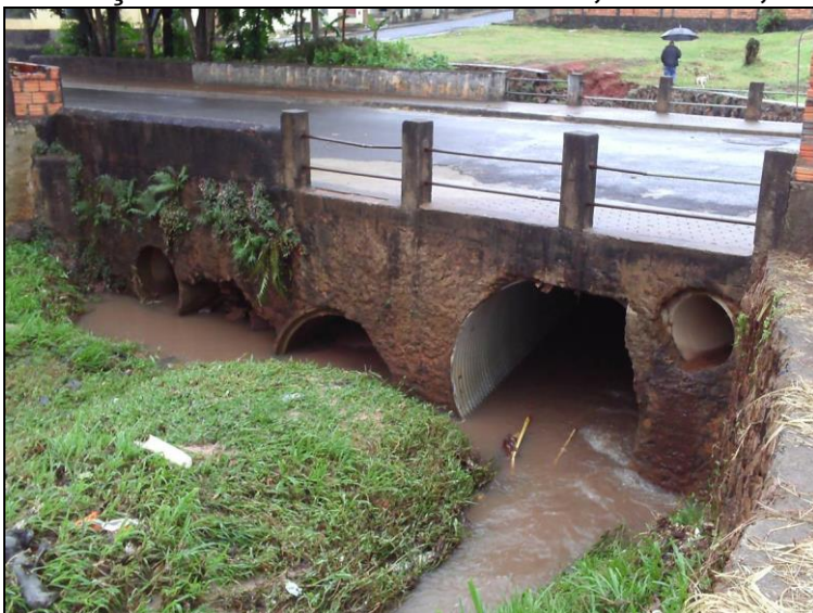
Fotos 7, 8 e 9.- Travessia da R: Salustiano Soares (Córr. Lageado) – tubulações com diâmetros de 60cm, 80cm e 1,5m
