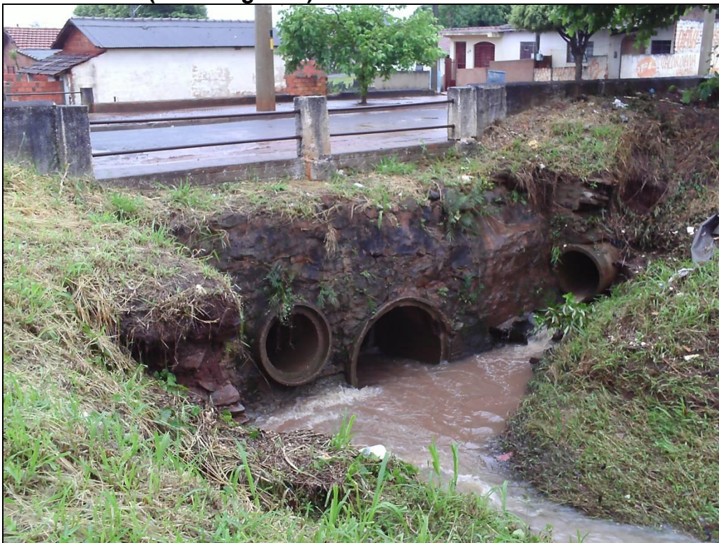
Foto 5.- Travessia da R: José Silveira Mello – tubos com diâmetros de 60cm e 80cm (Córr. Lageado)
