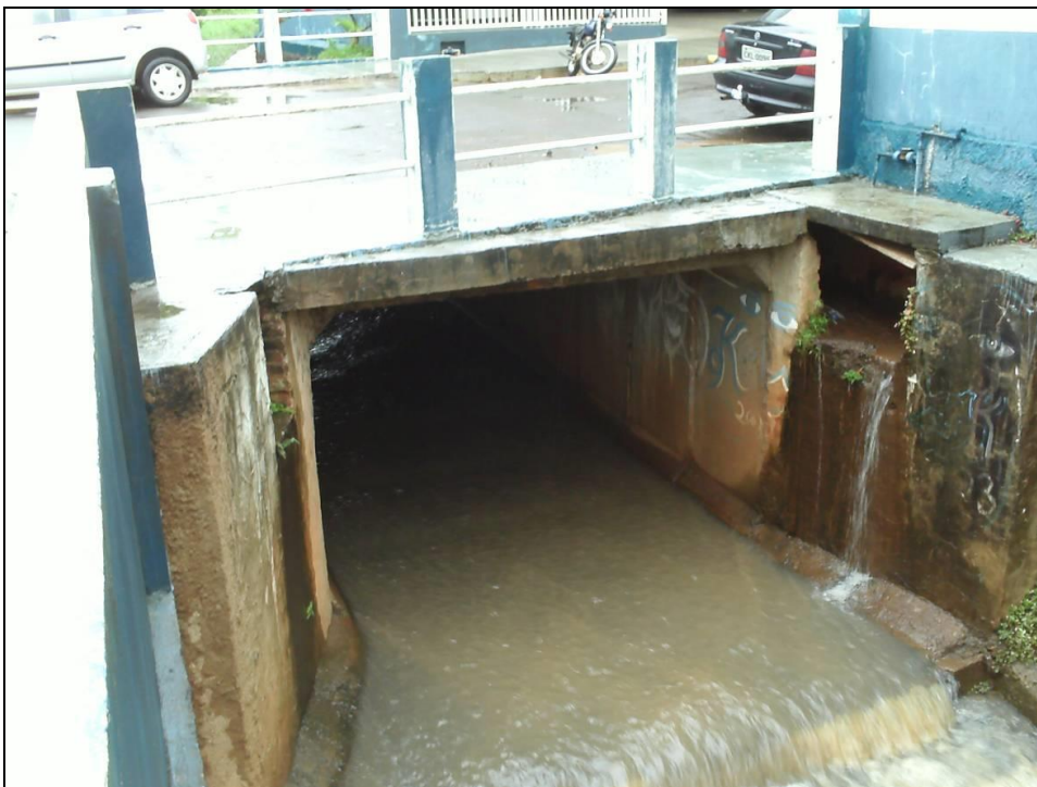
Foto 11.- Travessia sobre o Córr. Lageado (R: Duque de Caxias) – aduela de concreto de 2m 2
